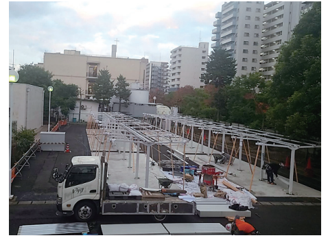
新駐輪場（工事中）
