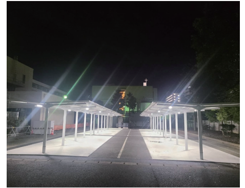
新駐輪場（完成）
